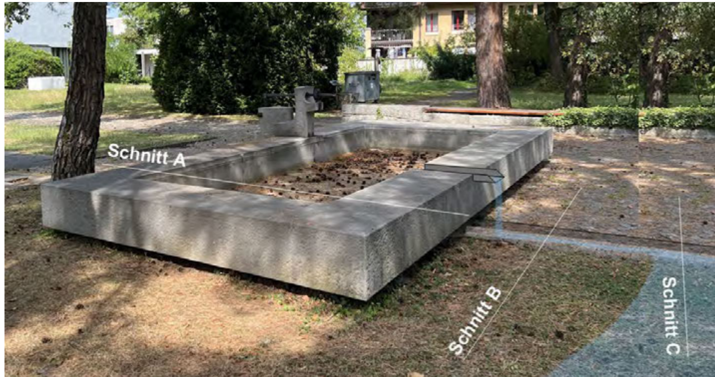
Sanieren, Tiefe reduzieren, Überlauf anbringen, Pflasterrinne erstellen
