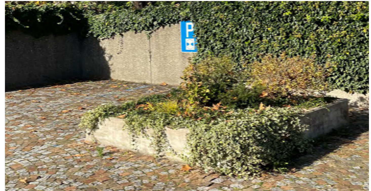
Pflanztrog -> Rückbau und Erstellung bodenebener Grünfläche
