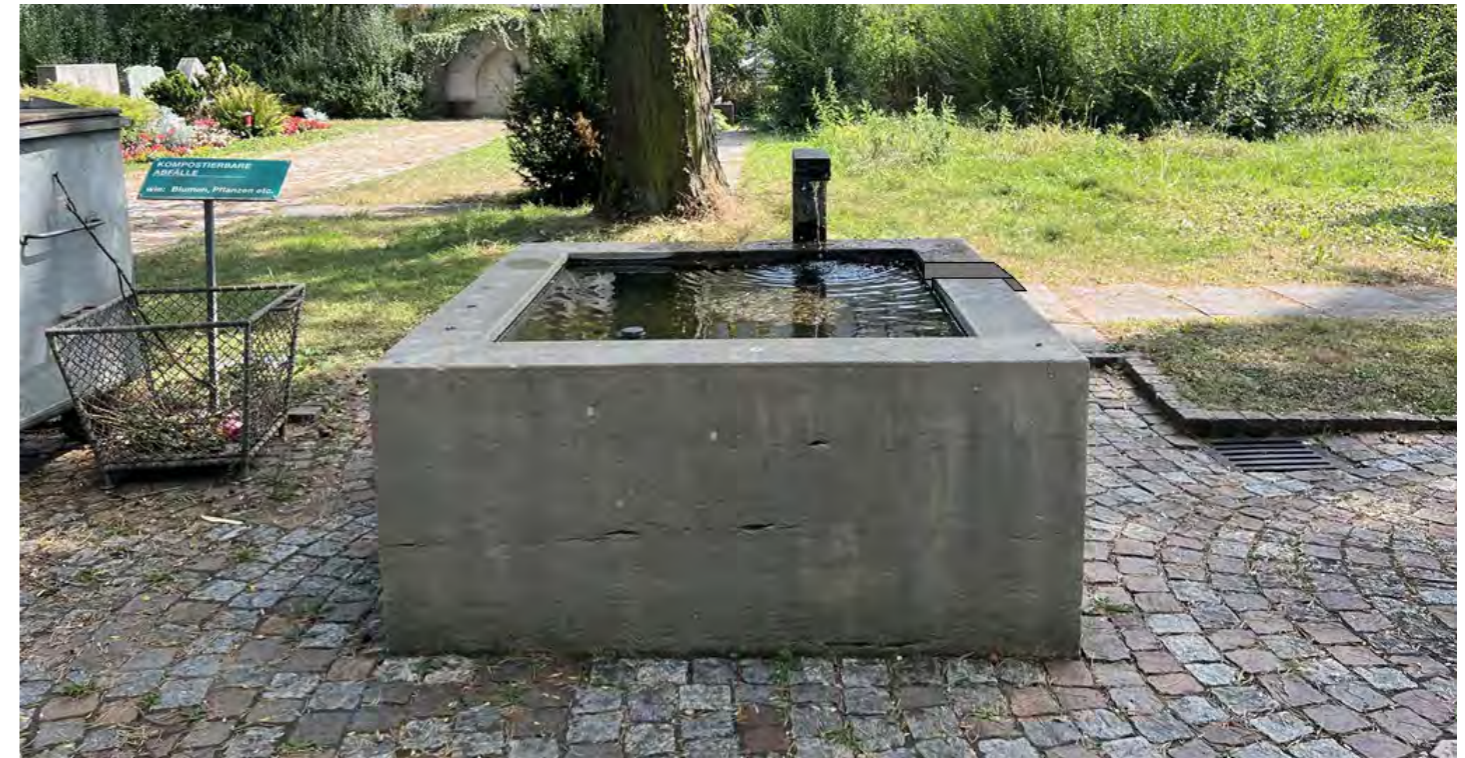
Überlauf anbringen, Pflasterrinne erstellen
